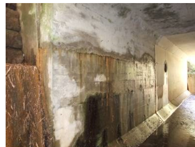
漏水・遊離石灰
