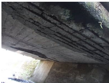
剥離・鉄筋露出
