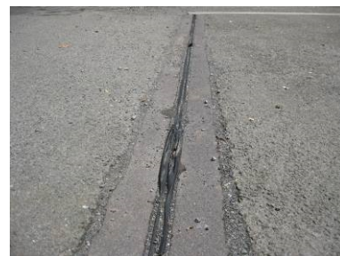
橋面（伸縮装置の異常）
