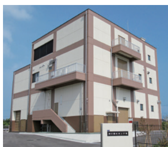
新潟口雨水ポンプ場
