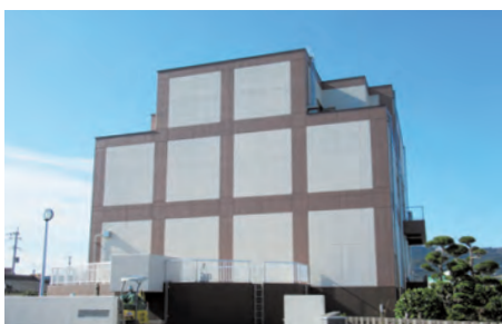
完成間近の新潟口雨水ポンプ場
