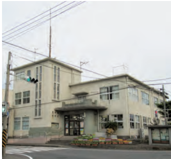
建て替えが予定されている山川庁舎
