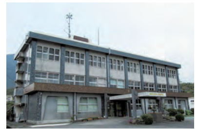
耐震補強と改修工事が予定されている開聞庁舎
