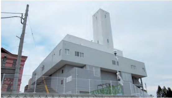
間もなく本稼働する新ごみ処理施設
