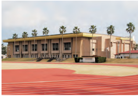
施設内の一部の利用が再開された指宿総合体育館
