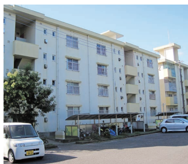
手摺り設置が望まれる市営住宅
