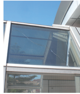
ひび割れた砂楽の天窓
