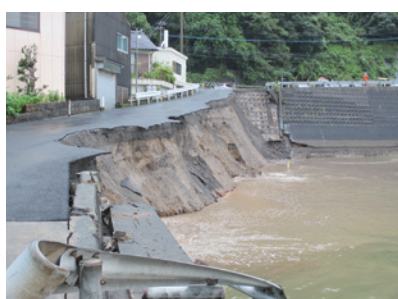
山川漁港海岸護岸崩落現場(くりや食堂前)
