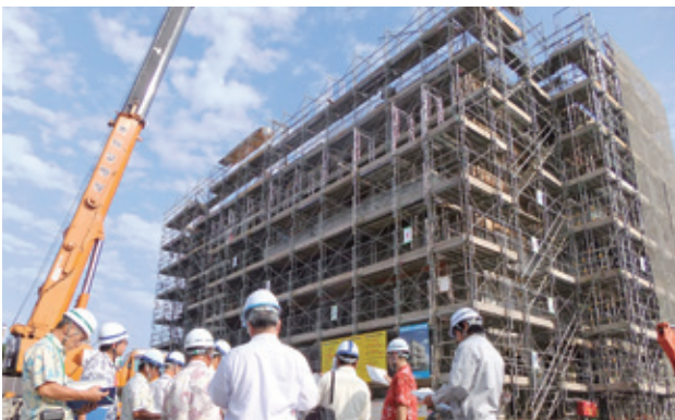
建設中の新潟口雨水ポンプ場
