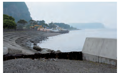
整備が進められている東方海岸の堤防
