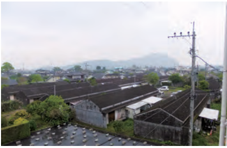
建て替えが予定されている敷領団地
