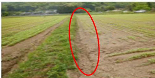
① 額縁明きよの施工
