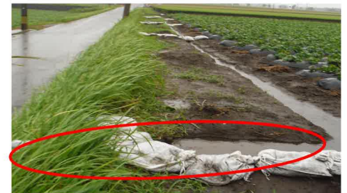
③ 明きよを排水路に接続
