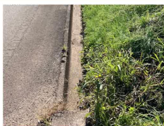
排水路の土砂を除去
