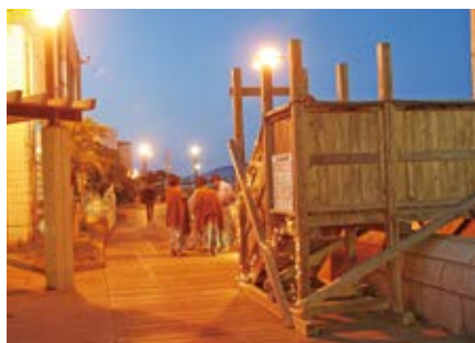
砂むし会館砂楽の仮設階段
