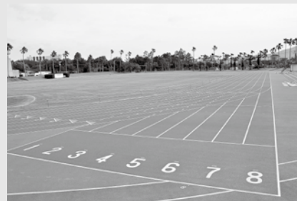
市営陸上競技場大規模改修工事費 4億453万円
