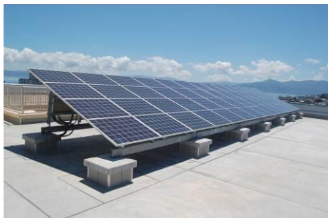
【太陽光パネル】
