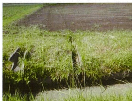
明きよを排水路へ接続
