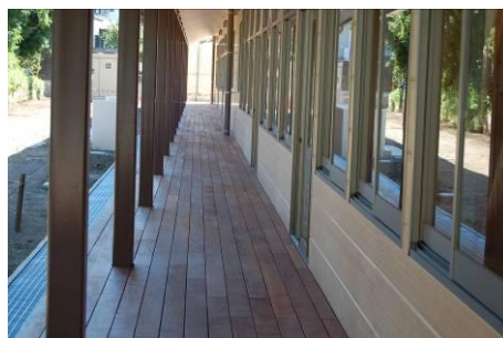
【木造校舎の柱廊】
