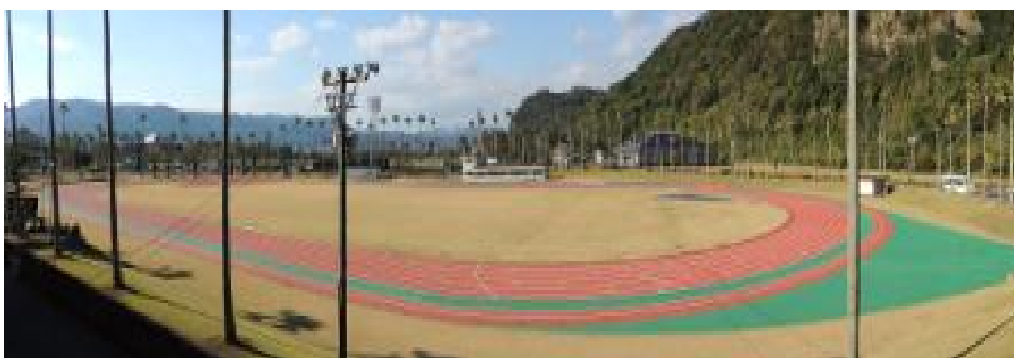
平成 23 年度に全面改修工事が終わり，平成 24 年 4 月にリニューアルオープンした市営陸上競技場
