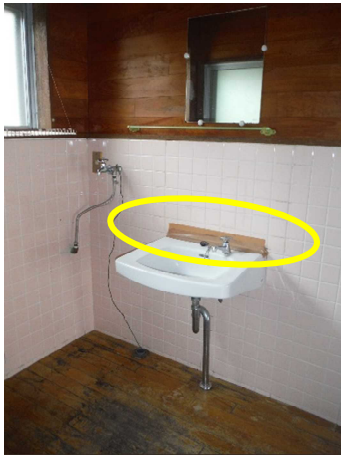
④壁面とのつなぎ目をガムテープで補修
