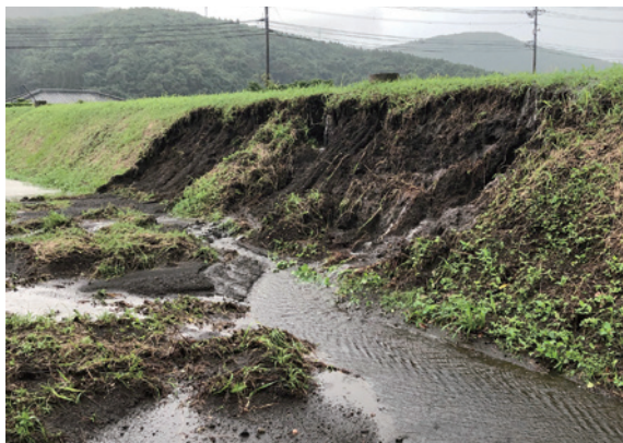
大雨により発生した法面の崩壊
