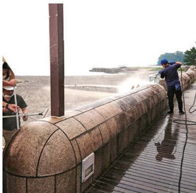
円弧状パラペットの洗浄作業の様子
