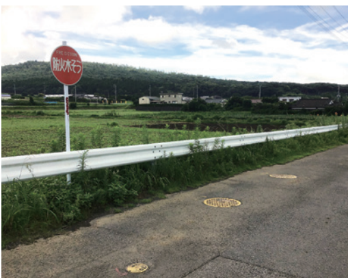
設置されている防火水槽
