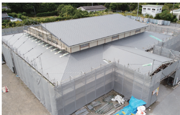
建設中の新開聞庁舎
