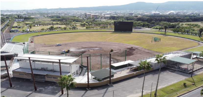
改修が進む市営野球場
