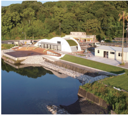
整備中の池田湖観光施設公園【愛称: IKEDAKO PAX (いけだ湖パクス)】
