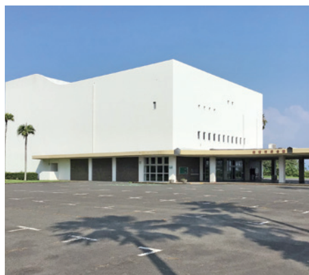
役目を終え解体される旧市民会館
