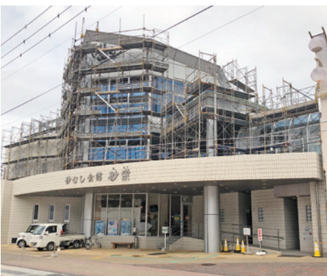
改修中の砂むし会館「砂楽」
