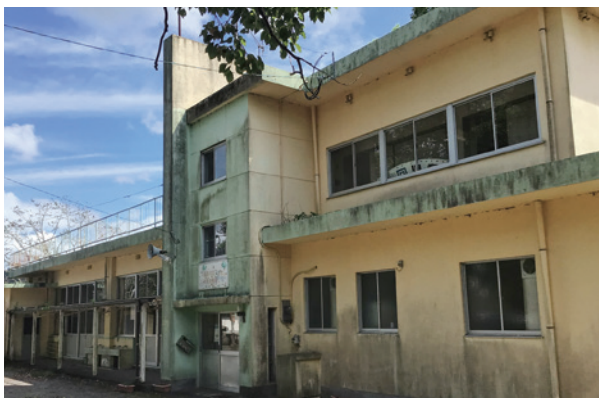
解体される旧開聞児童館
