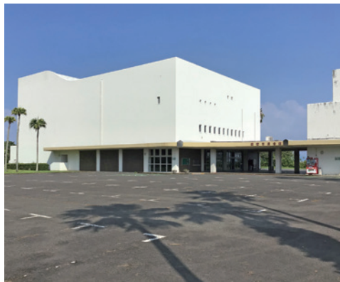
解体される旧市民会館
