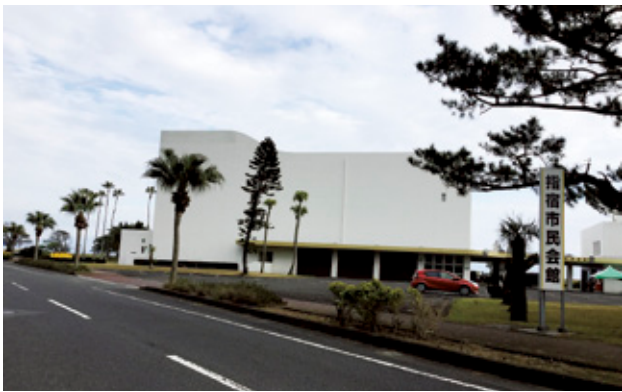
市民会館出入口の周辺
