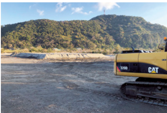
サッカー・多目的グラウンド造成地
