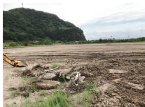
サッカー場建設予定地
