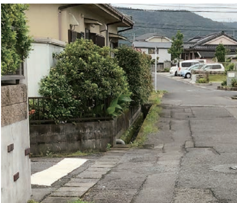
ふたがなく危険な側溝
