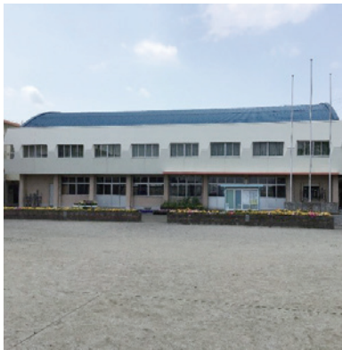
仮設教室が設置される大成小体育館
