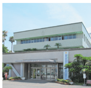
大規模改修工事を行う指宿庁舎
