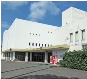
老朽化が進み建て替えが計画されている市民会館
