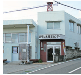
エアコン等が設置される 浜見ヶ水集落センター
