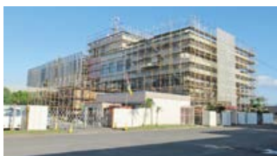
大規模改修工事中の指宿庁舎
