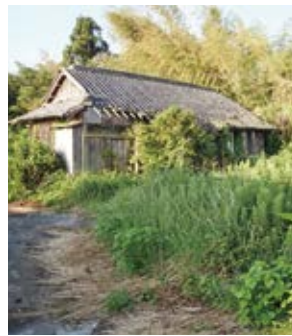
犯罪や事故の恐れもある放置されたままの空き家
