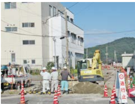
地元業者が施工中の十町土地区画整理事業
