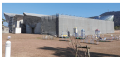
改修工事中のなのはな館
