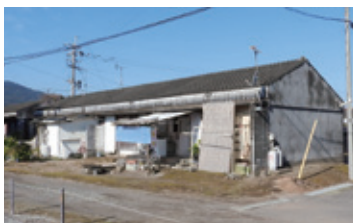
建て替えが計画されている敷領団地
