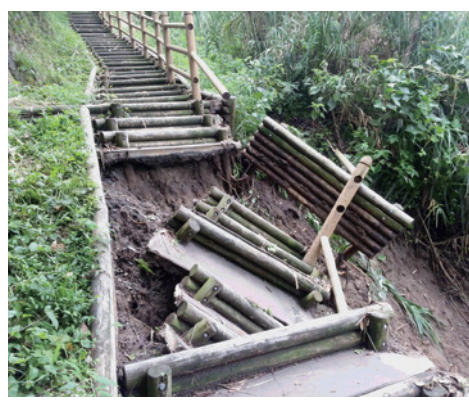
崩壊した遊歩道
