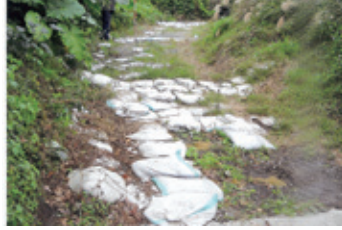
土のうが積まれた里道
