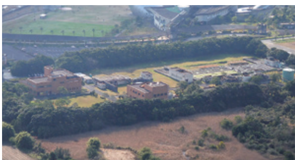
再構築(長寿命化)工事が行われる指宿市浄水苑
