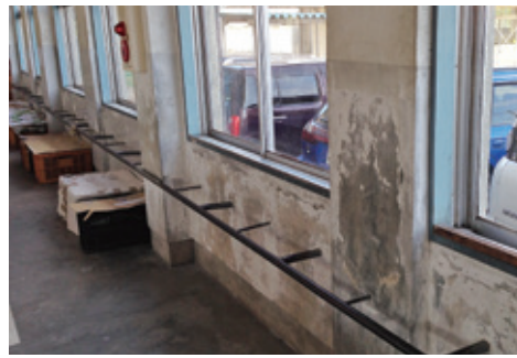
壁の塗装も剥げた開聞小の校舎
