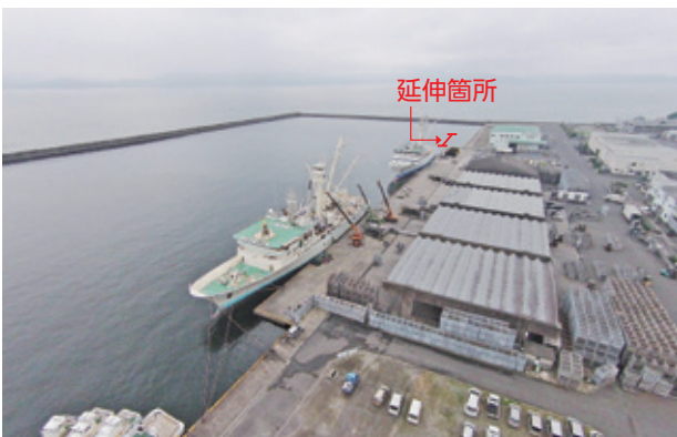
整備が待たれる山川港の外港
