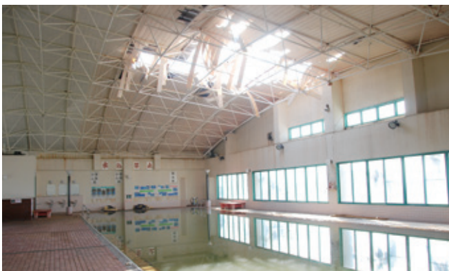
被災部分のプール屋根
