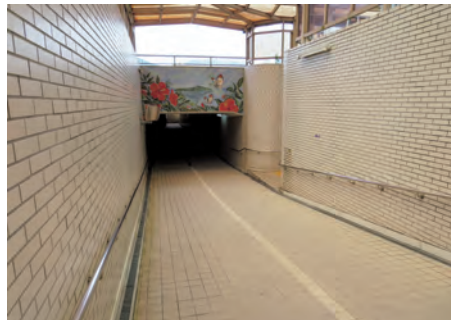
LED照明や広告パネルが設置される指宿駅地下道
