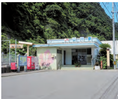
無人駅が解消される山川駅
