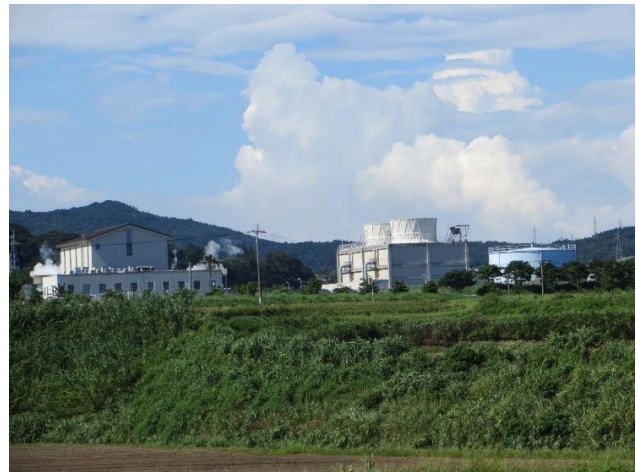
九州電力山川地熱発電所
