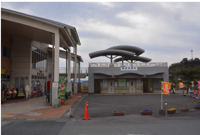
屋外トイレ(国所管)
