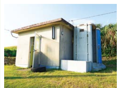
▲設置された屋外仮設トイレ(右側)
