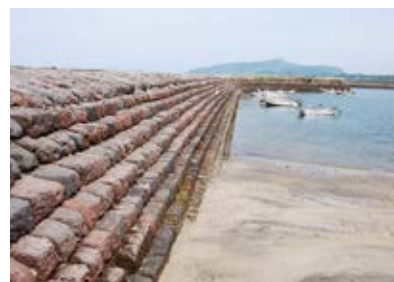
国登録有形文化財 宮ヶ浜港防波堤（捍海隄）
