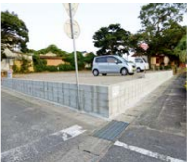
▲整備されたブロック塀
