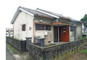
物件3: 旧魚見小学校教頭住宅
