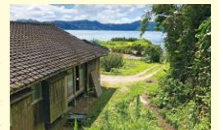
改装中の古民家
