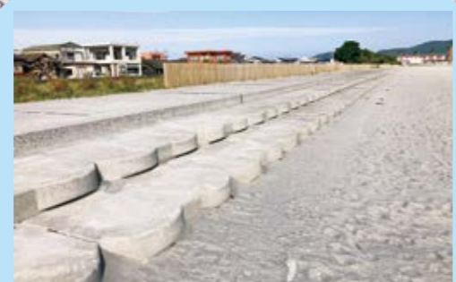
緩傾斜護岸 海岸線で波を防ぐ施設です。
