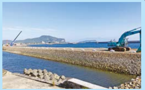
仮設道路 工事を行うために必要な道路です。
