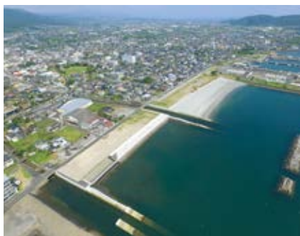
▲整備中の海岸（令和3年8月撮影）
