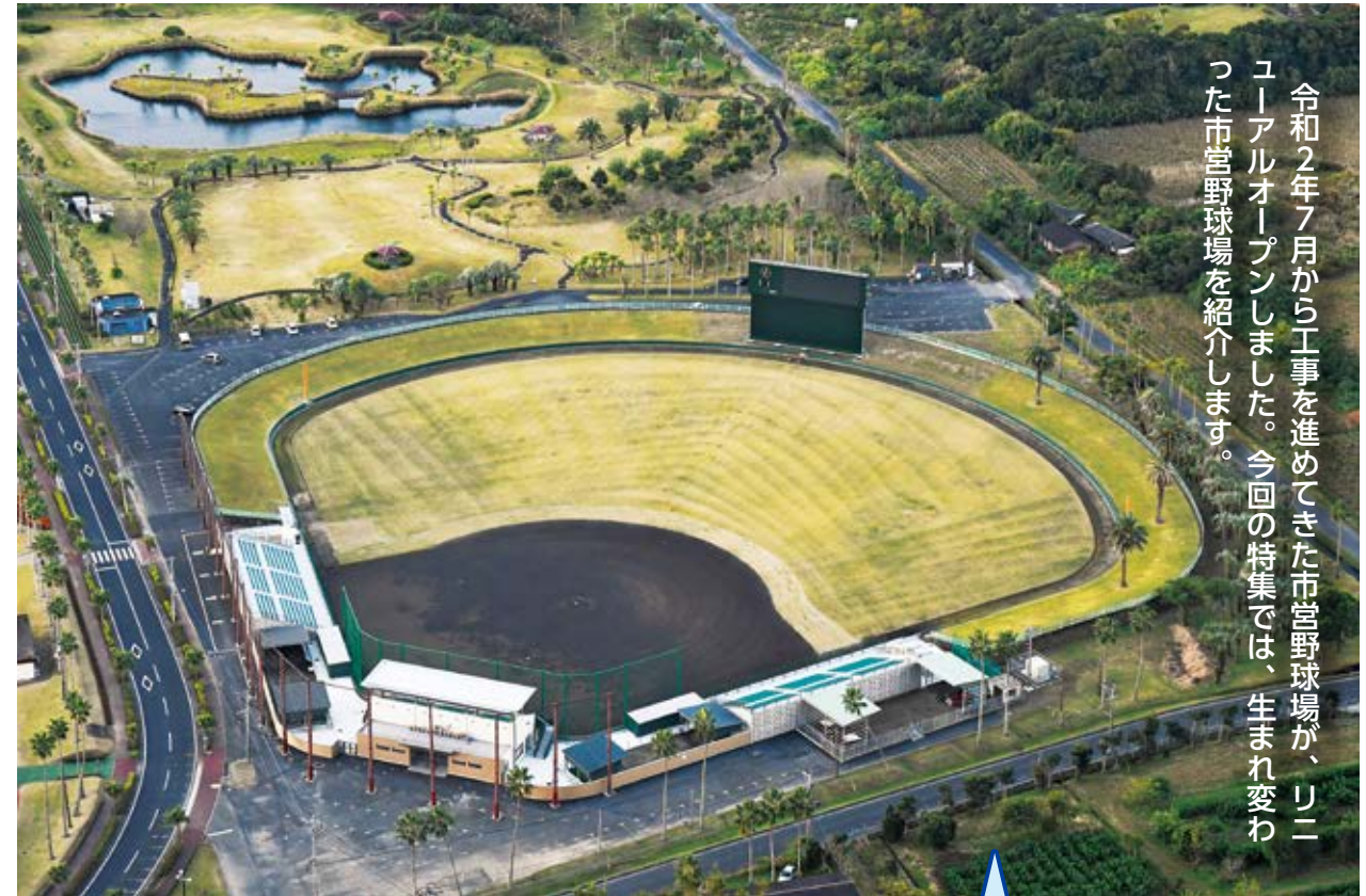
▼完成した市営野球場
