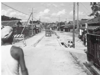
国道226号宮ヶ浜の舗装工事の写真(昭和34年ごろ)
