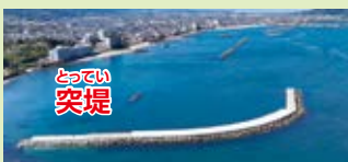
波を弱め、砂の流出を防ぐ突堤
