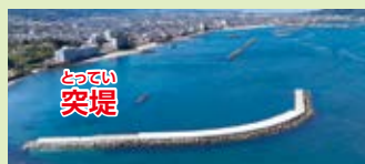
波を弱め、砂の流出を防ぐ突堤
