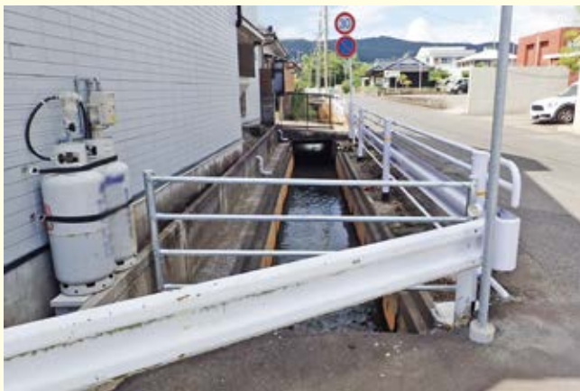
転落防止柵 さく の設置 (対策後)
