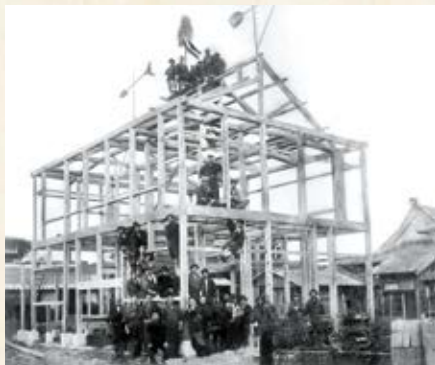
建設中の馬渡写真館。 高さ6.7mを誇る近代 的な建物で人々から注 目を集めた。
