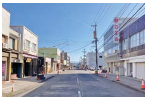
アーケード撤去後の指宿中央通り
