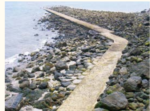
震洋艇滑走用コンクリート製スロープ
