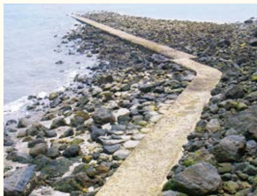
震洋艇滑走用コンクリート製スロープ
