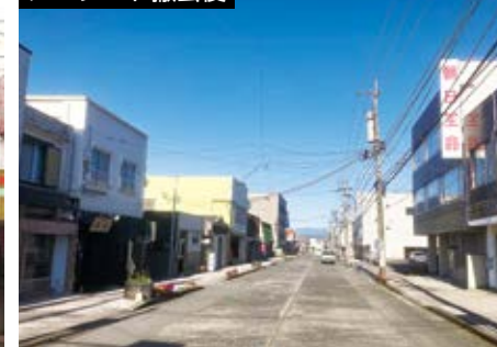
アーケード撤去後
