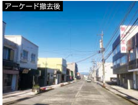
アーケード撤去後
