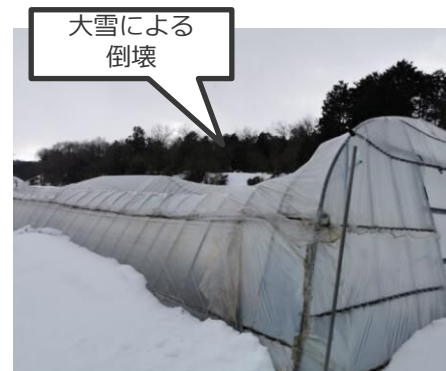
農業用ハウスの補強対策未実施
