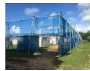
防風ネットの設置
