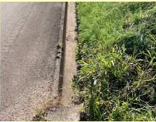
排水路の土砂を除去
